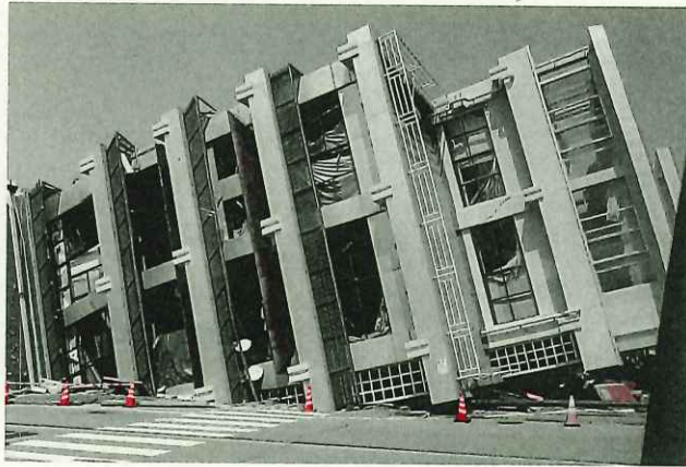
横倒しになったままのビル
