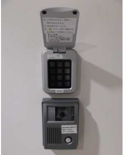
締切ドアの横に設置されたテンキーボックスとインターホン
