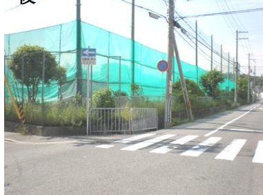
フェンス設置前
