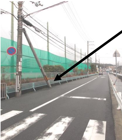
フェンス設置後
