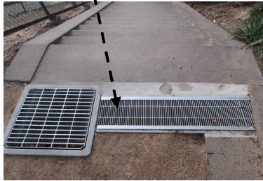
幅が広がった排水口
