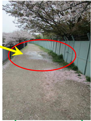
工事前の状態
