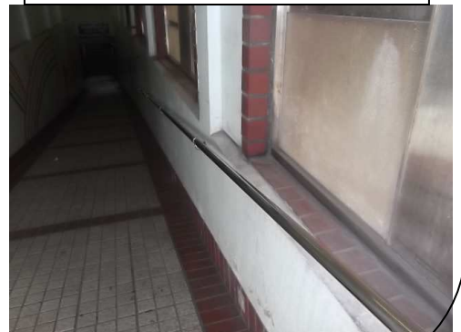
鳴尾地下道 スロープの手すり
