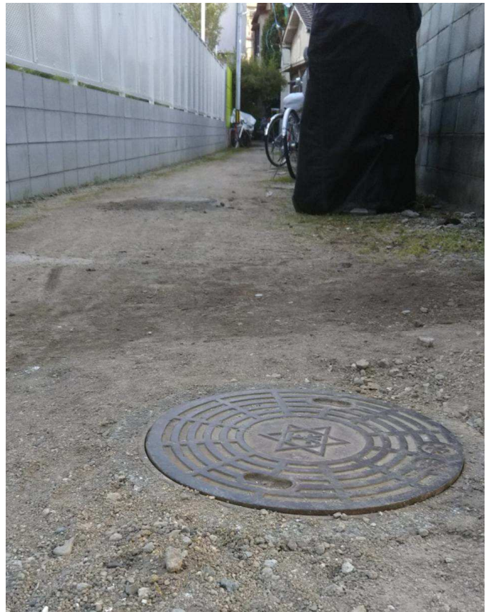
改修後のマンホール。平らになっています。
