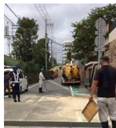
泥まみれの周辺道路
