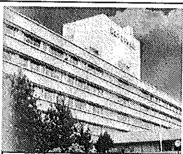
開院から36年経過した 林田町の中央病院
