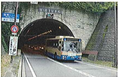
公共バスも通行料を負担して盤滝トンネルを通行
