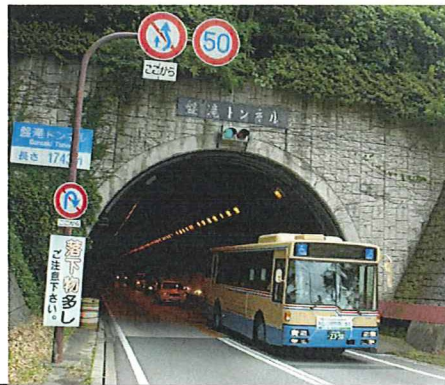
西宮の南北を結ぶ盤滝トンネル
